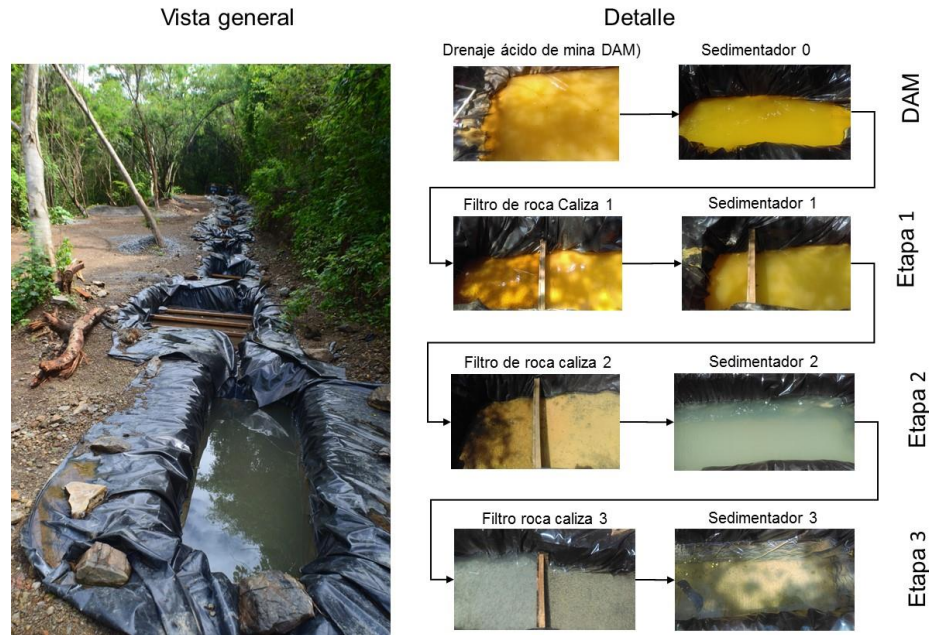
Figura 1. Tratamiento pasivo de drenaje ácido de mina, en tres etapas
