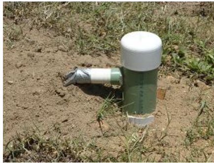
Figura M3. Instalación de Sonda de medición
